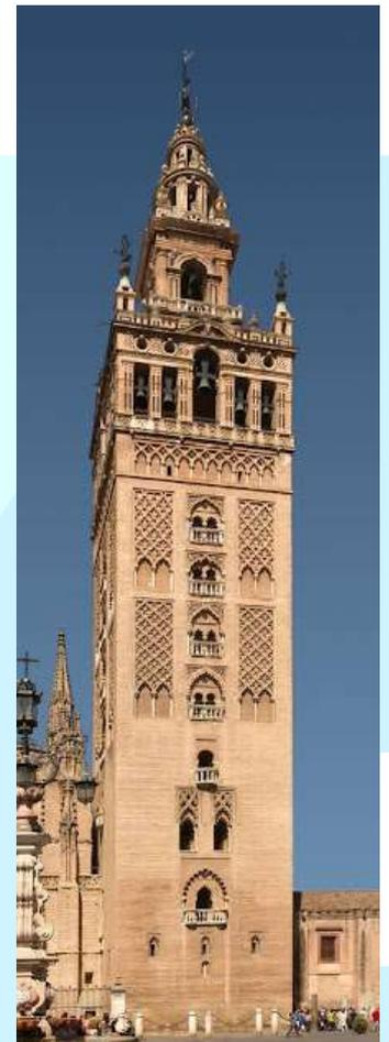
En el nivel inferior, los muros son lisos y en ellos se abren vanos en forma de arcos polilobulados y de herradura enmarcados en alfiz.
