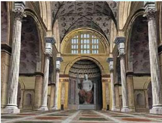
Las naves laterales , de 16 metros de ancho, están divididas en tres tramos perpendiculares a la nave central y se conectan entre ellas mediante arcos de medio punto. Están cubiertas con bóvedas de cañón con casetones que aligeran su peso. Los empujes se dirigen hacia los machones y los muros reforzados con contrafuertes exteriores. Las columnas que separan la nave principal de las laterales tienen función de articular el espacio.
