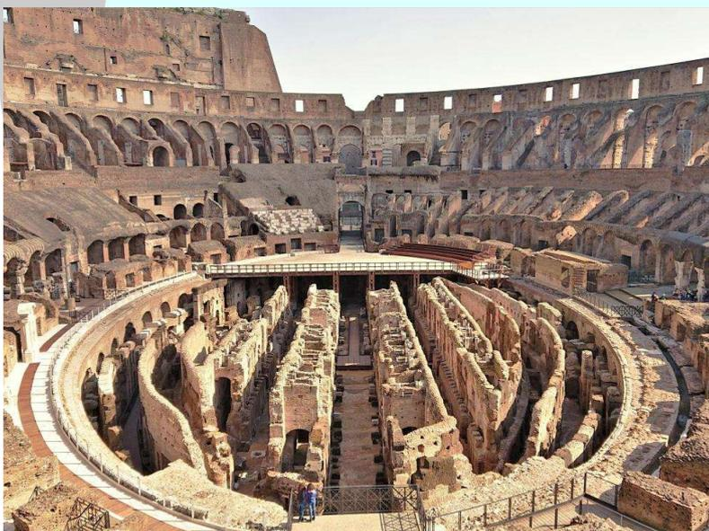
Este genial sistema permitió la construcción de kilómetros de pasillos y galerías anulares, coronadas por bóvedas de cañón y de arista. De esta manera, 50.000 espectadores podían evacuar el edificio en solo tres minutos.
