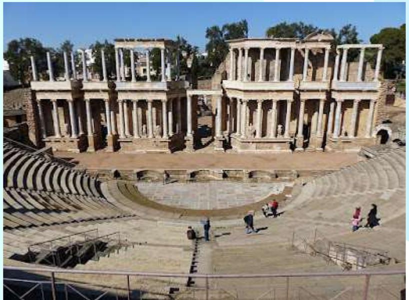
El **Teatro Romano de Mérida**, como otros edificios de la época romana, estuvo construido con nuevas técnicas arquitectónicas. En este caso destaca por el empleo del **Opus Caementicium** (una especie de hormigón), que se vierte sobre una serie de moldes o encofrado dando lugar a la estructura básica, este hormigón sería recubierto después con mármoles y otros elementos decorativos.
