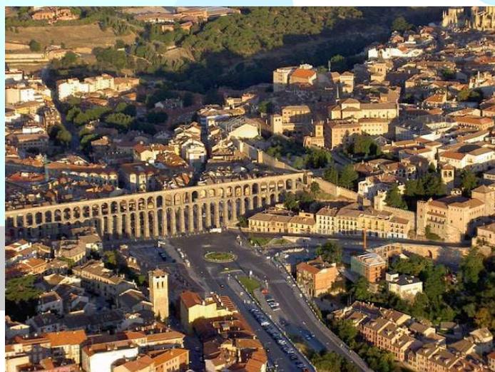
Al llegar a la ciudad el acueducto se resuelve en doble arquería: el tamaño de la inferior varia según el desnivel del terreno, la arquería superior tiene siempre el mismo tamaño y encima de esta un ático en forma de U por donde circula el agua. Las arquerías se estructuran o compartimentan mediante molduras o líneas de imposta.
