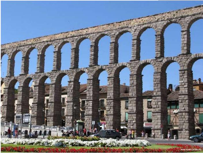
Es un ejemplo de la unión del sistema adintelado y del abovedado. El sistema adintelado sería la conducción en forma de U mientras que el resto son los arcos de medio punto.
