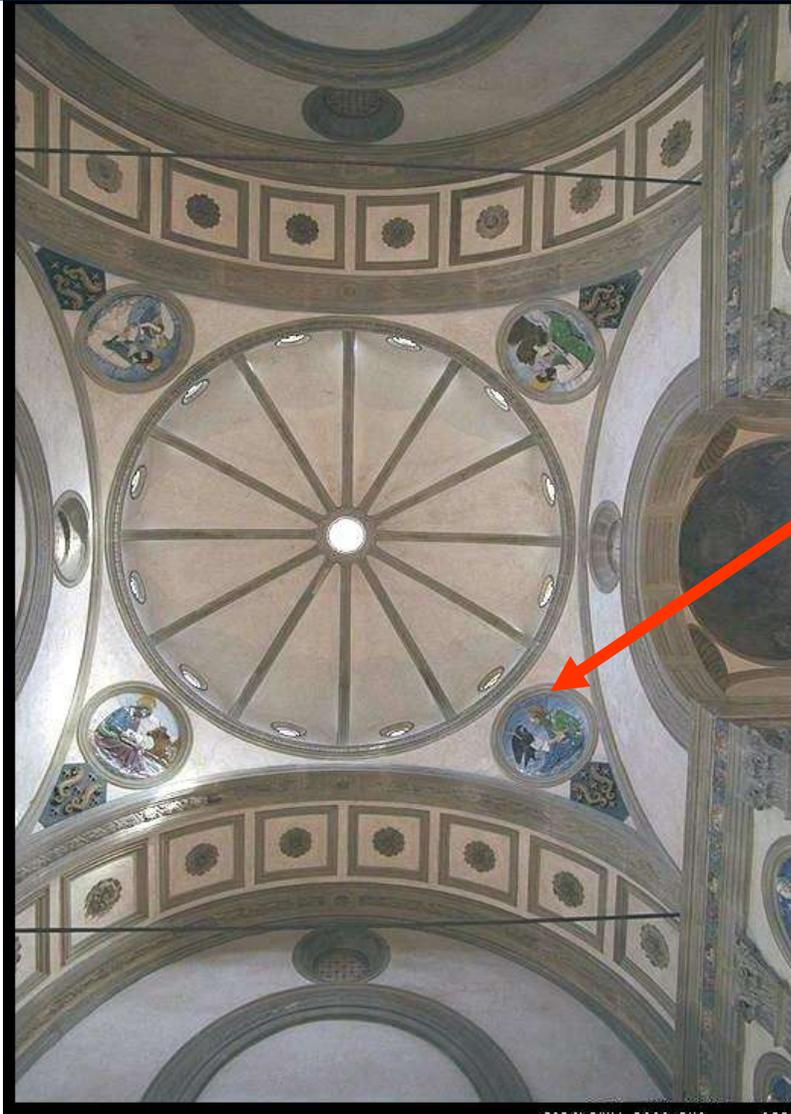
**Pechina:** Cada uno de los cuatro triángulos curvilíneos sobre los que se sustenta una cúpula. Sirven para pasar de la planta cuadrada a la circular.
