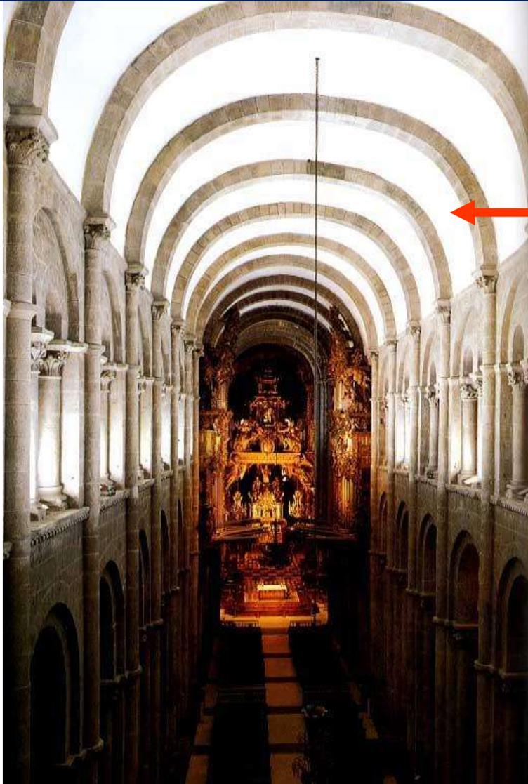
Cubierta curva que resulta del desarrollo longitudinal de un arco de medio punto, sobre dos soportes paralelos.
